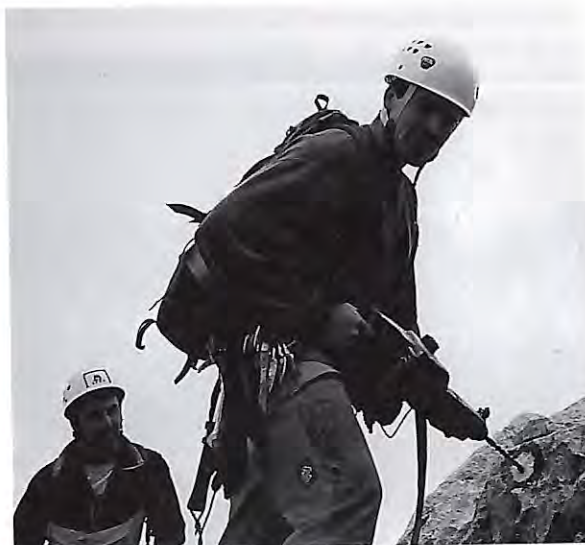
Ennio Rizzotti, guida alpina, impegnato nei lavori di ristrutturazione delle placche italiane al monte Mangart.
