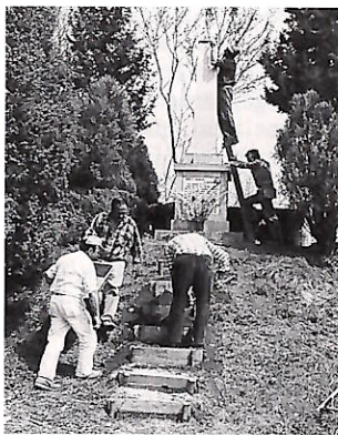
Alpini majanesi durante i lavori di ripristino.
