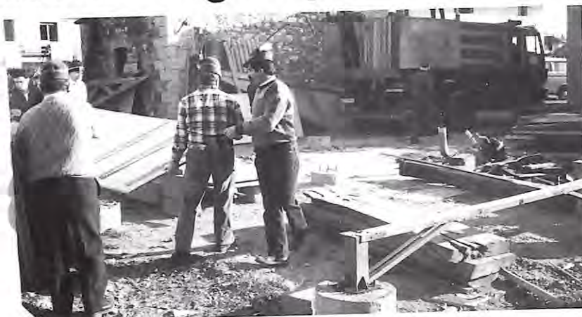
Gli Alpini di Barrea e di Buia durante i lavori di smontaggio del prefabbricato.
