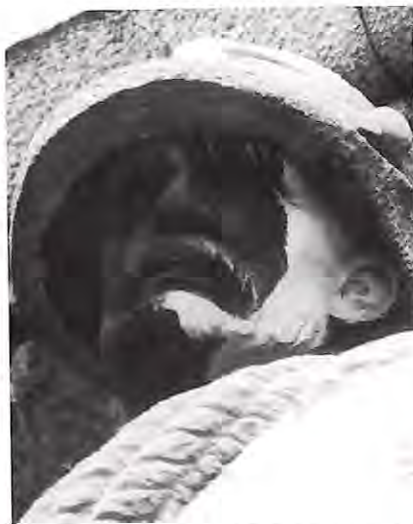
Particolare del degrado delle statue del Tempio Ossario.
