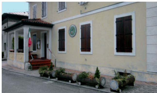
La sede a Tramonti di Sopra nei locali della Vecchia latteria
