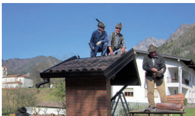
Intervento nella cappella votiva all'ingresso del paese di Tramonti di Sopra
