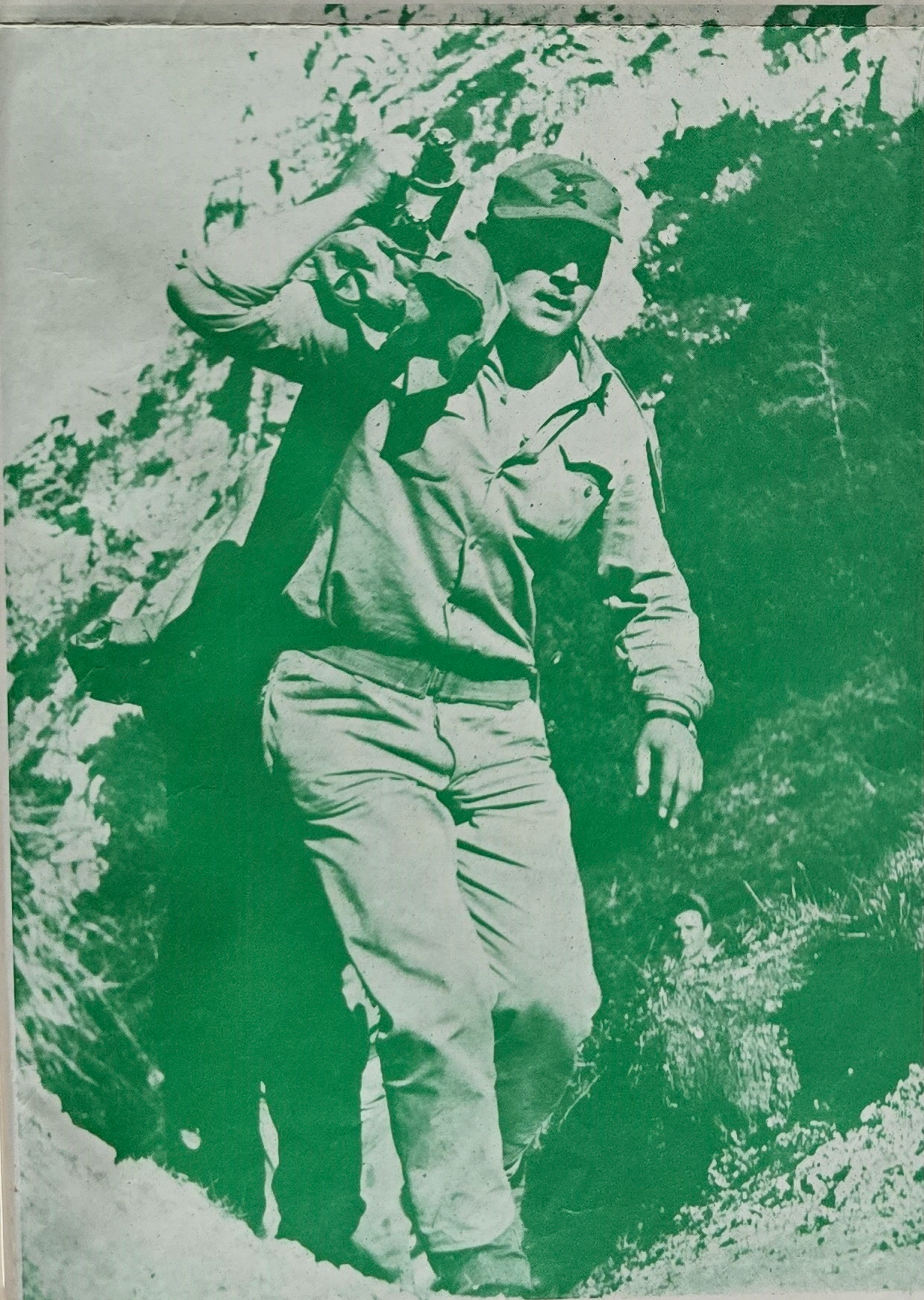
Scavalcamiento passo Enghe.
