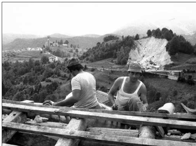
Alpini al lavoro sul tetto
