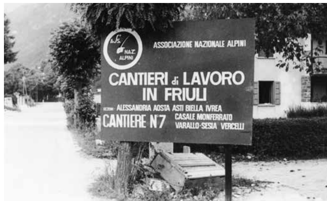
Cantiere n.7 - Moggio
