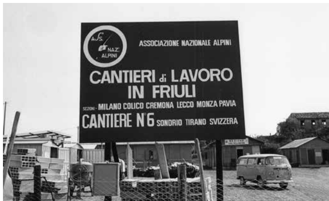
Cantiere n.6 - Majano
