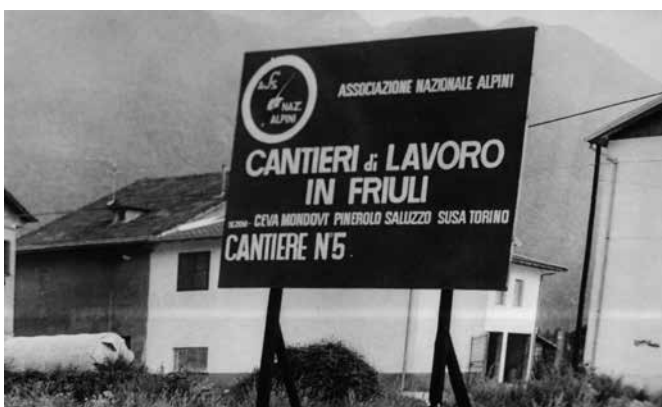
Cantiere n.5 - Villa Santina
