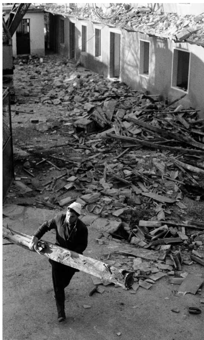
Si recuperano le travi della casa in demolizione
