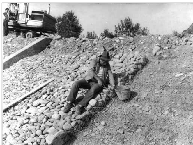
Sistemazione delle massicciate
