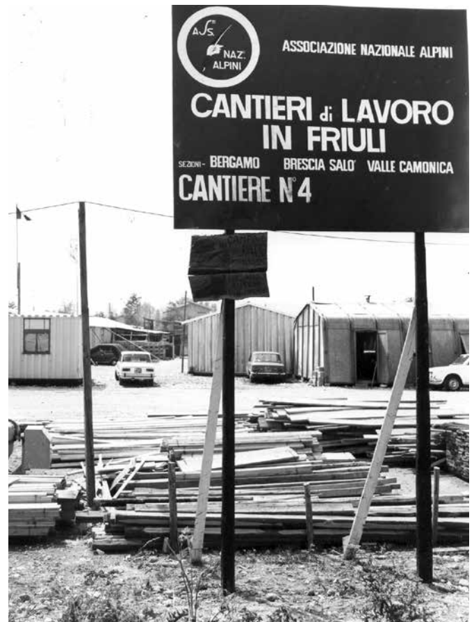
Cantiere n.4 - Campagnola di Gemona
