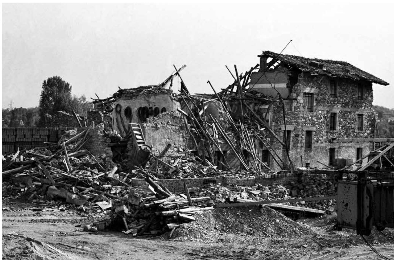
Fabbricati devastati dalla furia del terremoto
