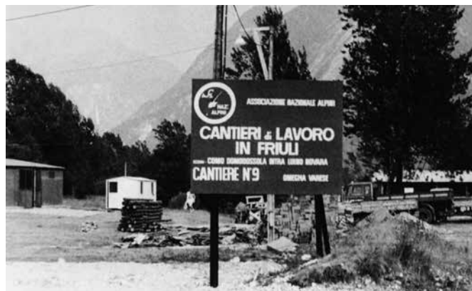
Cantiere n.9 - Cavazzo Carnico
