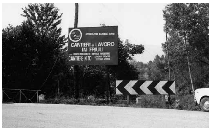
Cantiere n.10 - Pinzano al Tagliamento
