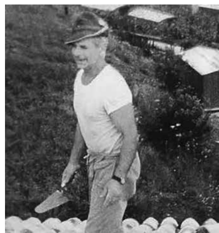
Bruno Infanti al lavoro nel cantiere 11 di Vedronza
