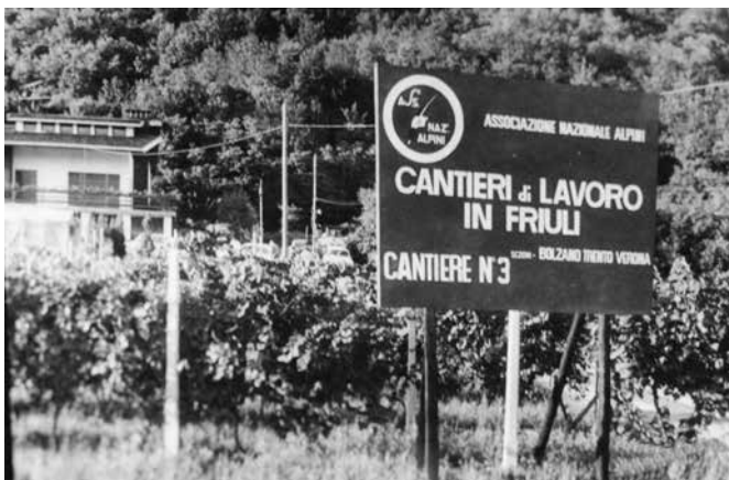
Cantiere n.3 - Buja
