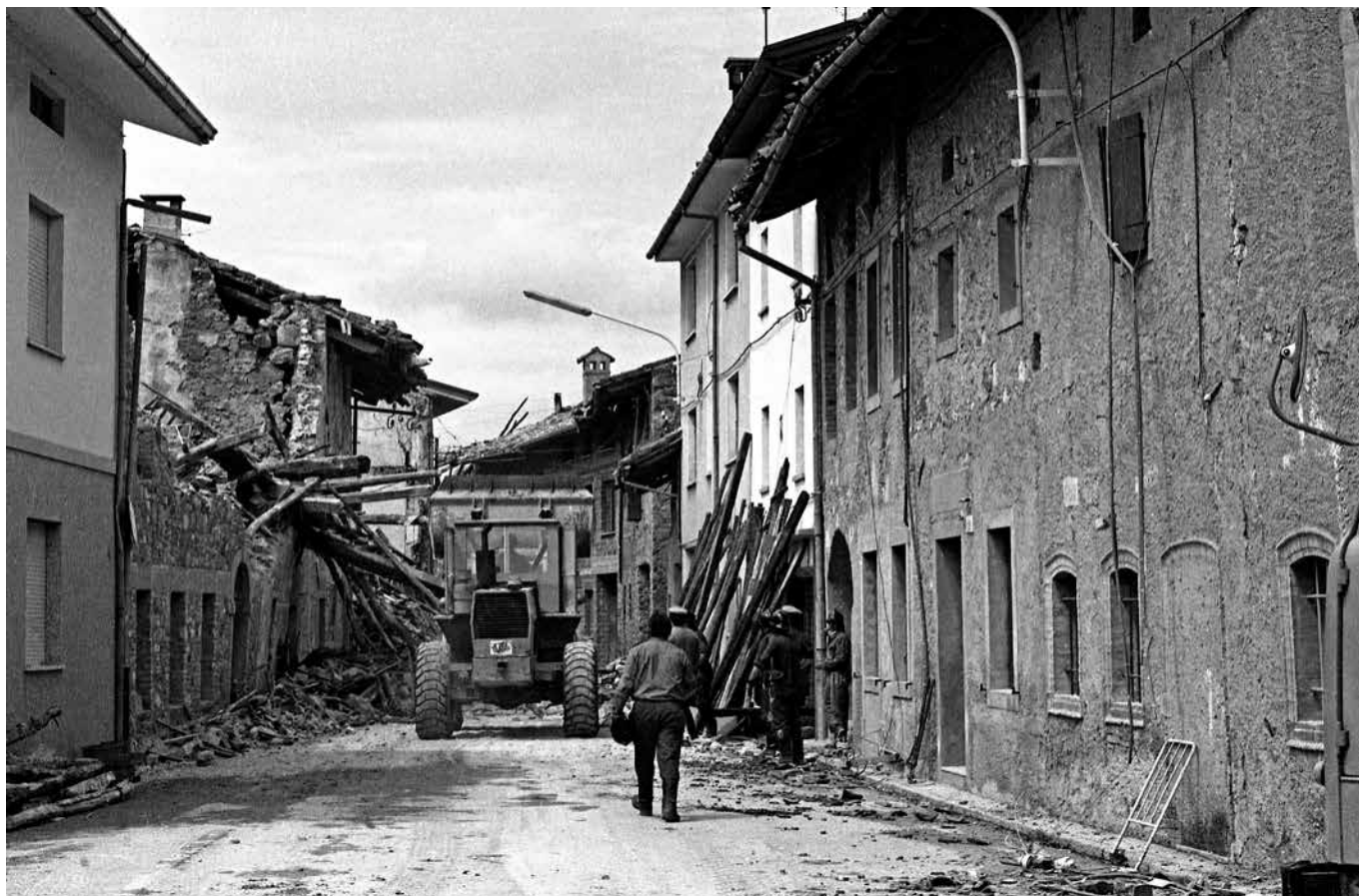
Si demoliscono gli edifici pericolanti
