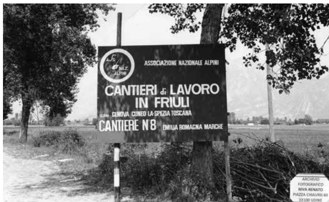
Cantiere n.8 - Osoppo
