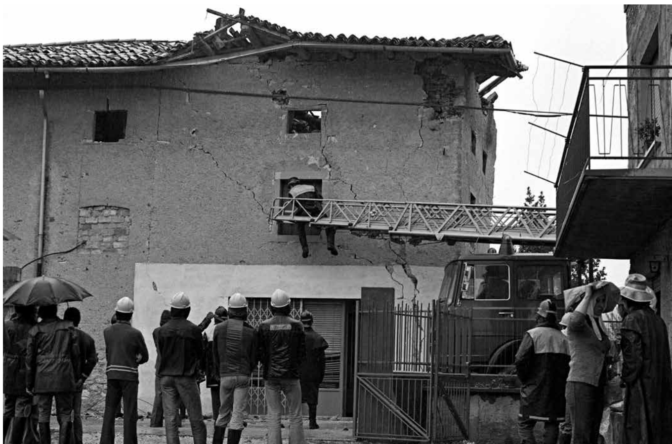
I Vigili del fuoco recuperano quanto possibile prima della demolizione del fabbricato
