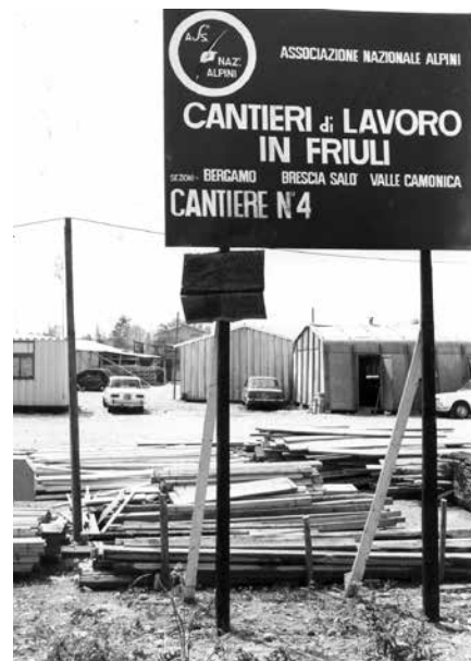
Ringraziamento per il cantiere n. 4
