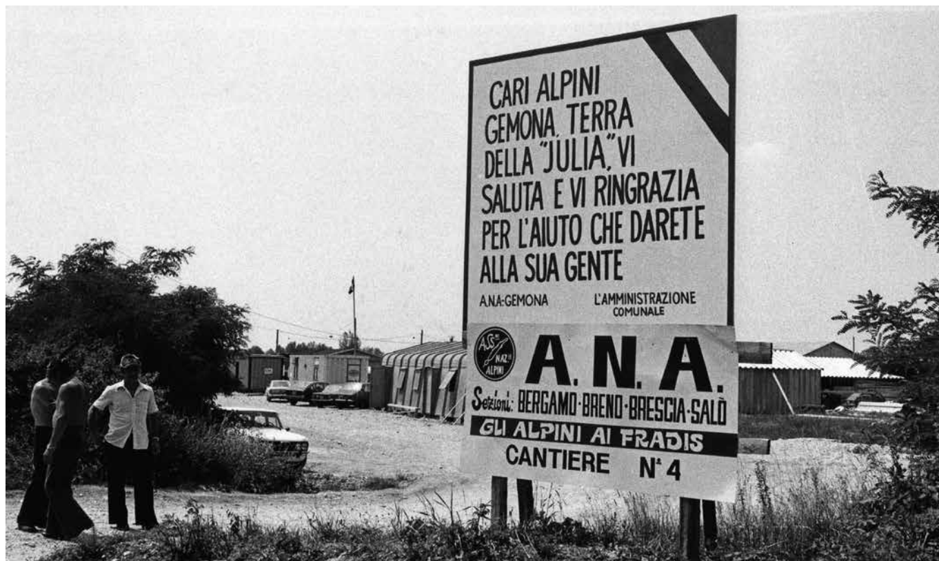
Cantiere n. 4 a Campagnola di Gemona
