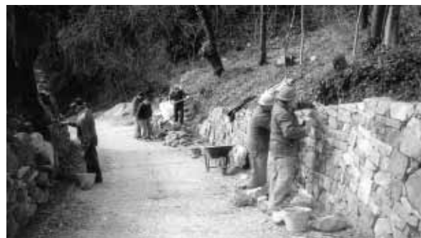
Alpini bujesi ripristinano le vecchie mura della strada Camartino - Monte.
